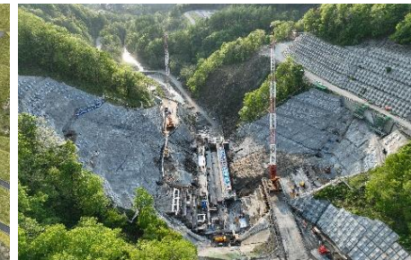
三笠ぽんべつダム (工事中の写真)
