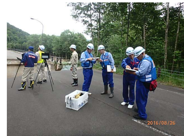
被災橋梁の現地調査状況②
