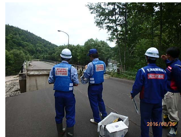
被災橋梁の現地調査状況①
