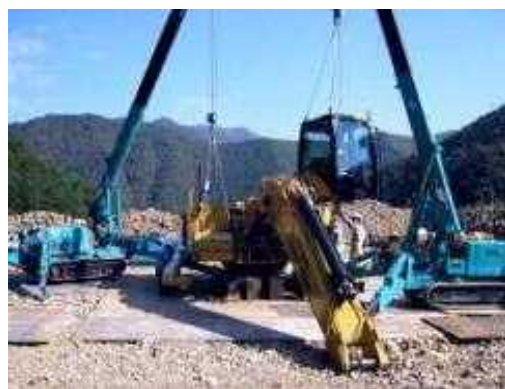
組立作業状況
