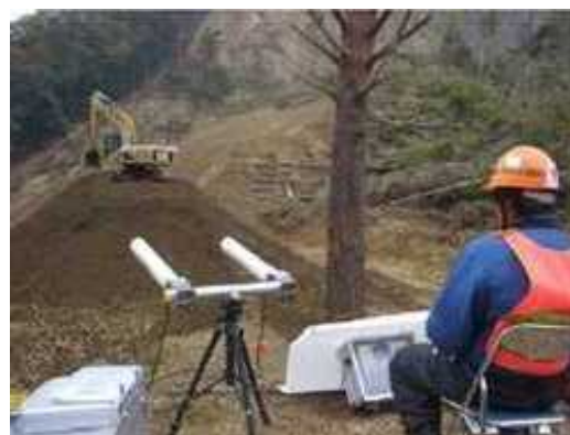
遠隔作業状況
