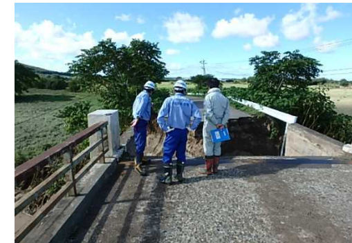
被災橋梁の現地確認
