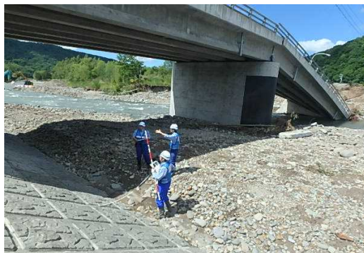
被災橋梁の現地調査
