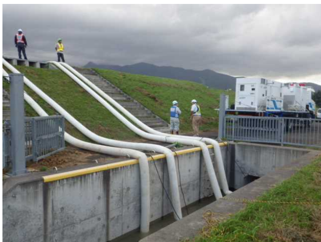
富良野排水樋門(富良野市)での排水ポンプ車作業状況①
