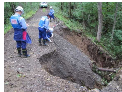
9月8日 町道の被災状況調査
