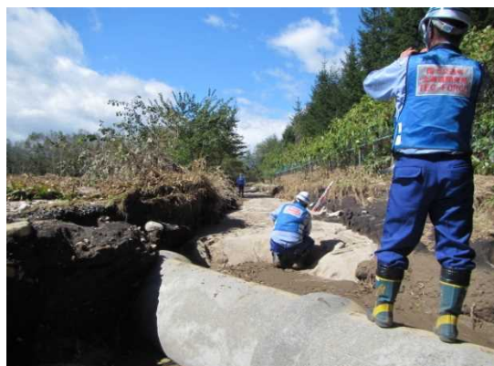
9月10日 町道の被災状況調査
