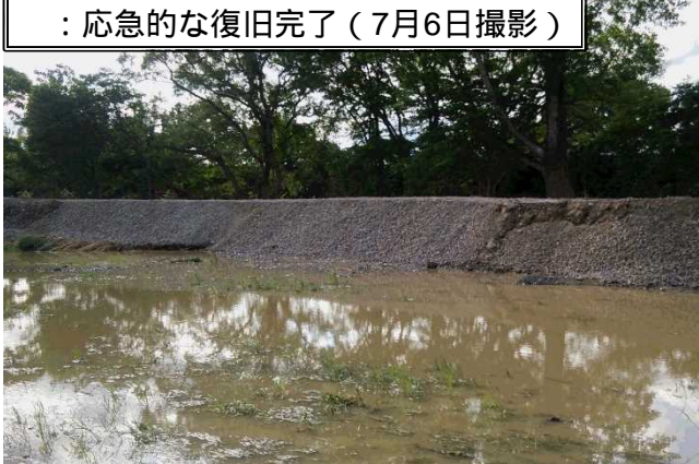
: 応急的な復旧完了(7月6日撮影)
