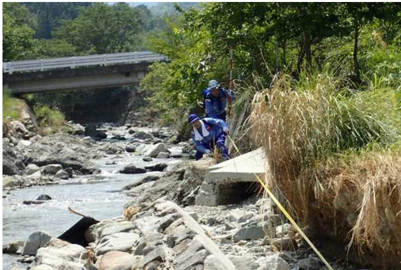
河川現地調査の様子(河津川)
