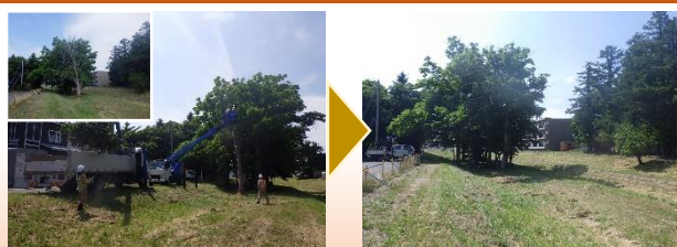
立枯木撤去(伏籠支線排水右岸KP1.8)
