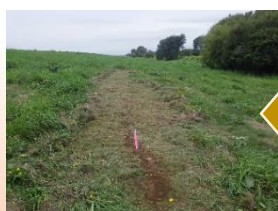
法面亀裂の補修(石狩川左岸KP15.4)
