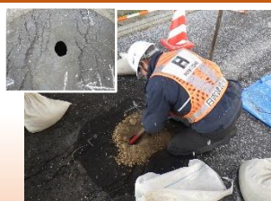
天端陥没箇所穴埋め(望月寒川左岸KP1.4)
