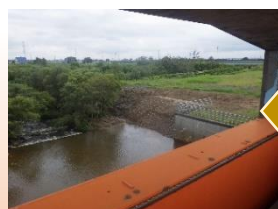
堆積土砂撤去(当別川 材木川水門)
