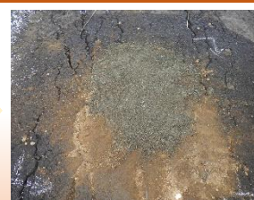
天端陥没箇所穴埋め(望月寒川左岸KP1.4)
