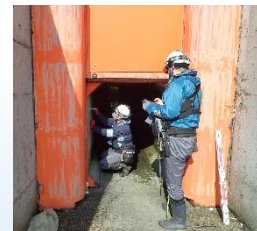
構造物点検状況
