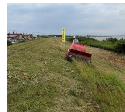
堤防の除草作業状況
