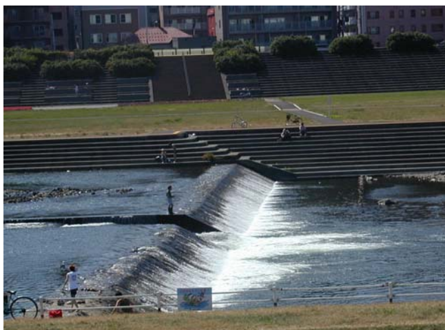
床止周辺に発生する渦流(改修前の5号床止)
