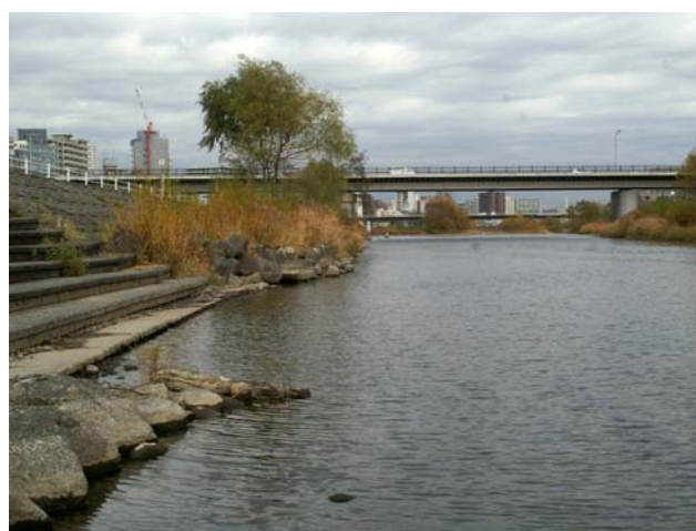
滞筋が護岸に近接している箇所
