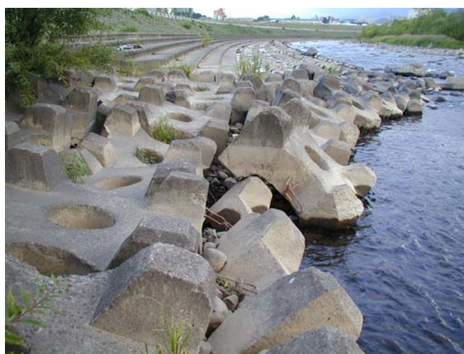
根固ブロック
