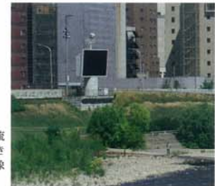
■河川情報表示板は、大雨やダム放流で川の水位が上がって危険なときなど、危機回避のための情報や気象情報などを提供する施設です。
