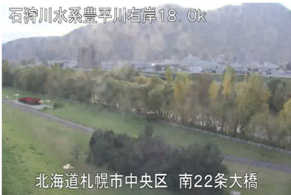
写真 4-5 CCTV カメラの視認性の低下 【管理面】
