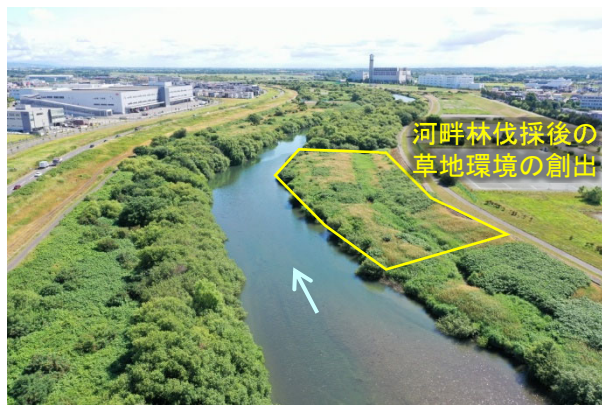
豊水大橋下流（令和6年7月 UAV 撮影）
