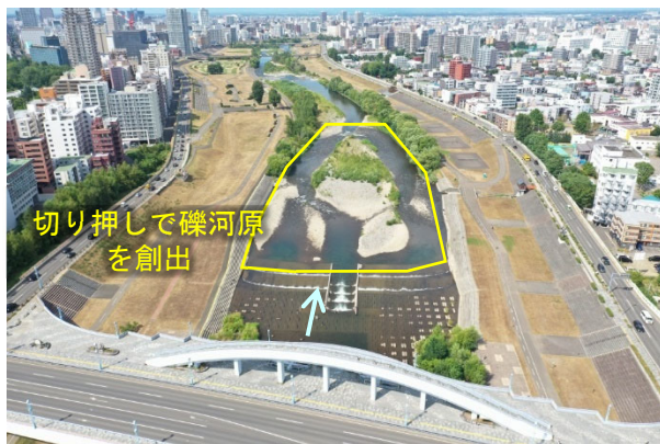
幌平橋下流（令和6年7月 UAV 撮影）
