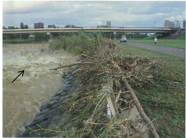
写真 4-2 流木の発生・堆積 (南 19 条大橋上流 H23. 9. 6 出水) 【治水面】
