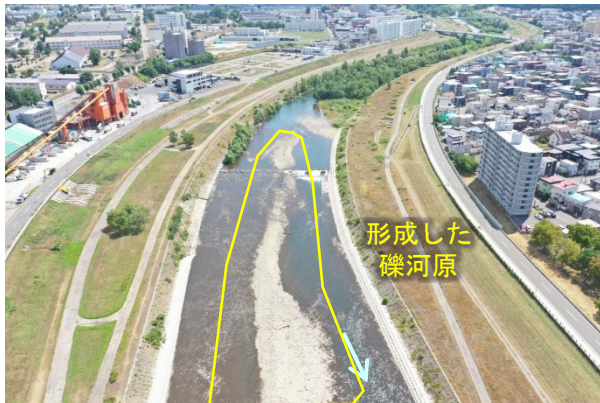
ミュンベン大橋上流（令和6年7月UAV撮影）
