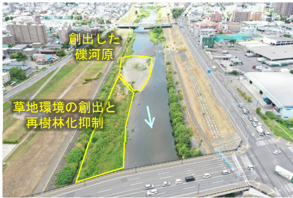
平和大橋上流（令和6年7月 UAV 撮影）
