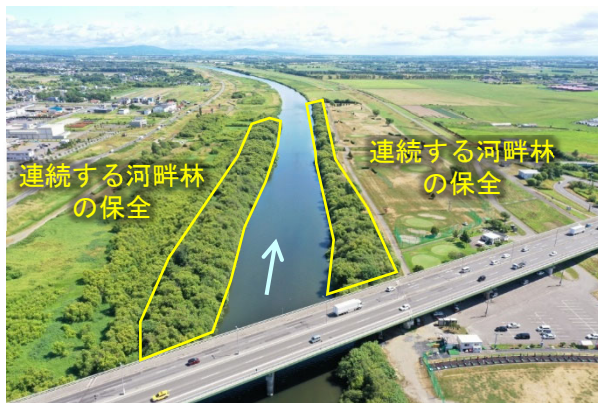
雁来大橋下流（令和6年7月 UAV 撮影）
