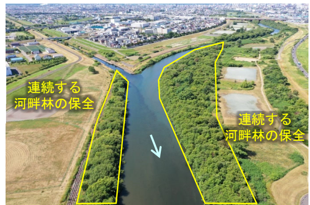
雁来大橋上流（令和6年7月 UAV 撮影）
