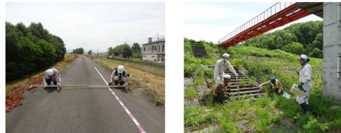
堤防点検の様子
