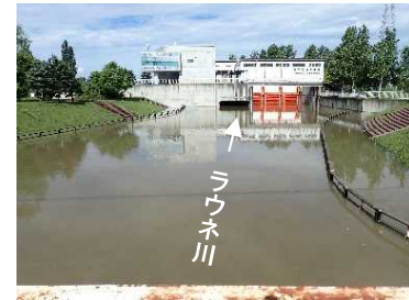
池の前排水機場
