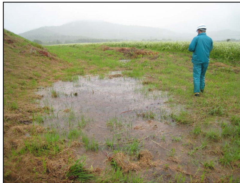
職員による堤防点検 雨竜川 長留内築堤
