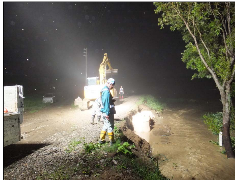
職員による堤防点検(夜間) 雨竜川 ペンケ築堤
