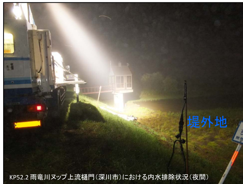
KP52.2 雨竜川ヌップ上流樋門(深川市)における内水排除状況
