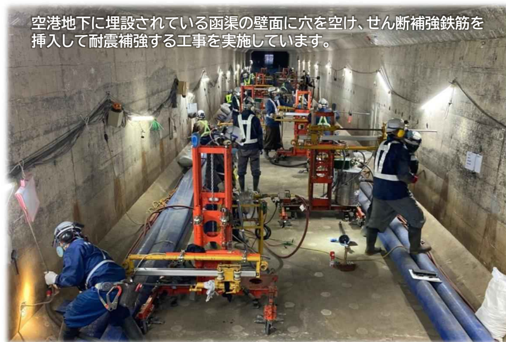
【美沢川函渠耐震補強 施工状況】
