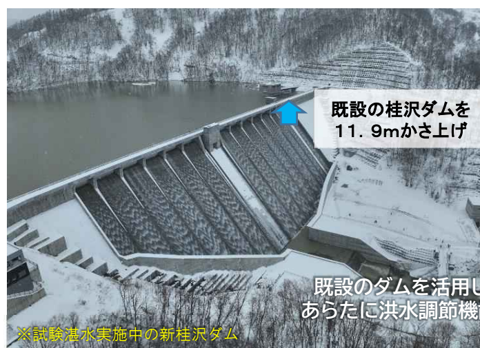
【幾春別川総合開発事業(新桂沢ダム)】
