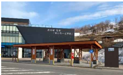
妊婦向け屋根付駐車場 (石狩「あいロード厚田」)
