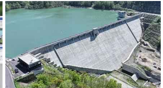
直轄初の同軸かさ上げをした新桂沢ダム
