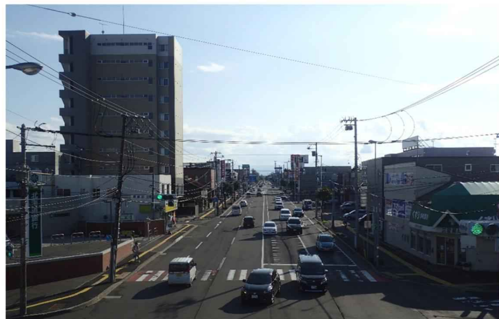
【整備前】(国道12号江別市野幌町)
