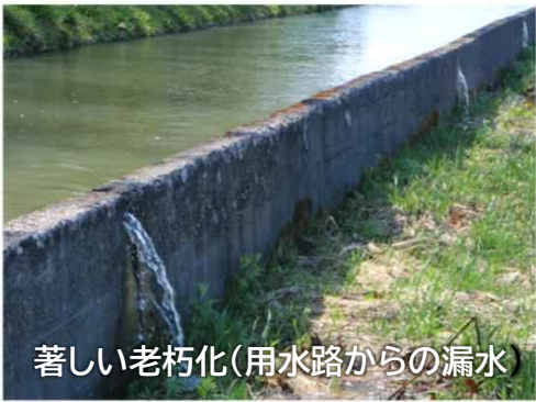
【農業水利施設(用水路)の整備】
