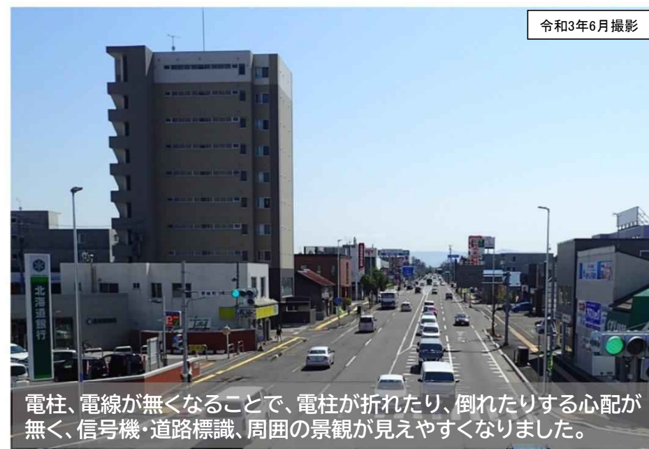
【整備後】(国道12号江別市野幌町)
