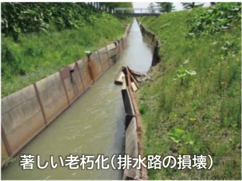
【農業水利施設(排水路)の整備】
