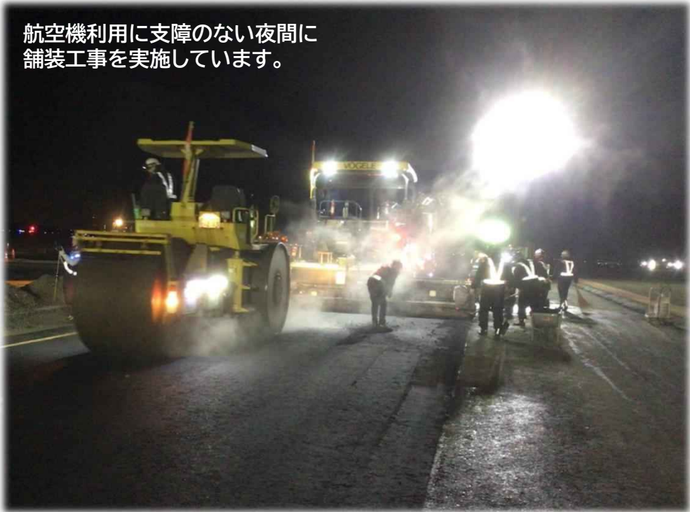
【末端取付誘導路複線化 施工状況】
