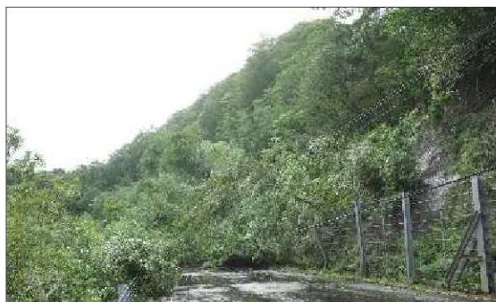
【表層崩壊箇所の現地状況】
