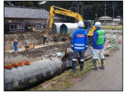
【復旧工事の状況】
