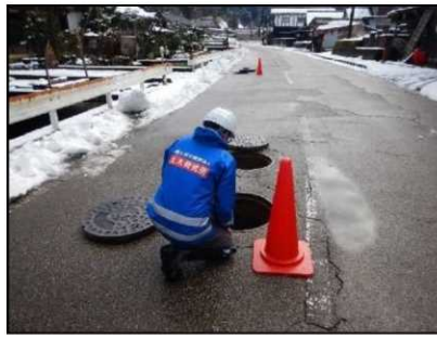
【被災施設の調査】
