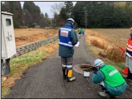
【農業集落排水施設の調査】
