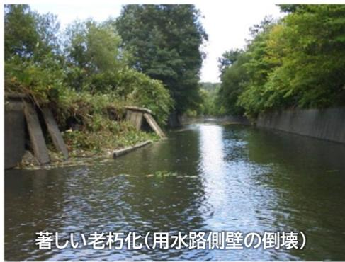
著しい老朽化(用水路側壁の倒壊)
