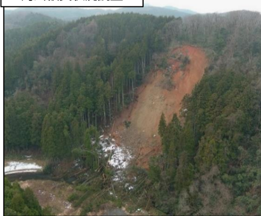
河川被災状況調査
