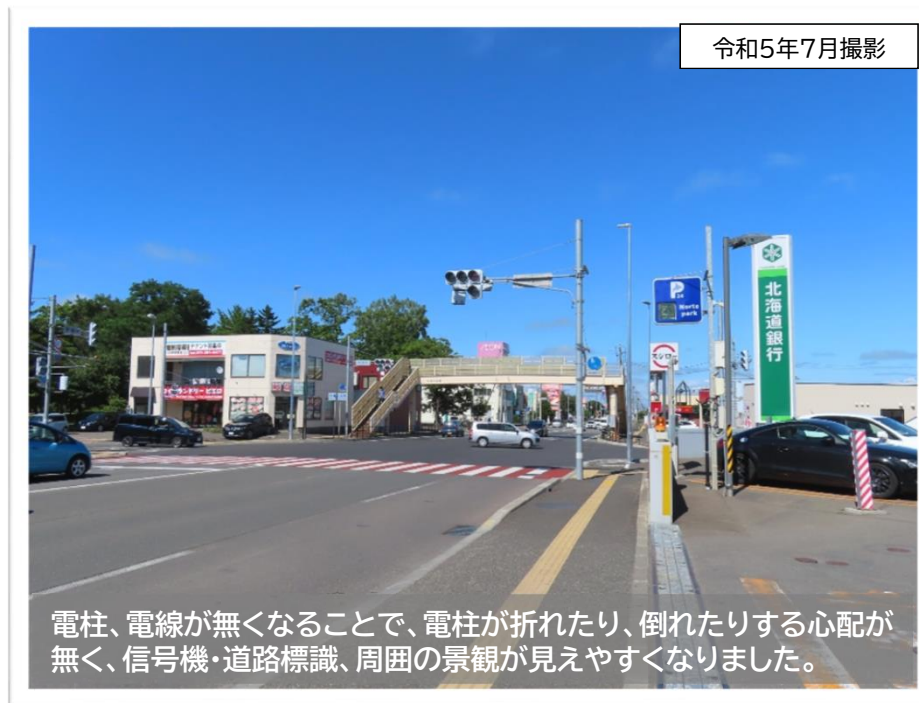
【整備後】(国道12号江別市野幌町)
