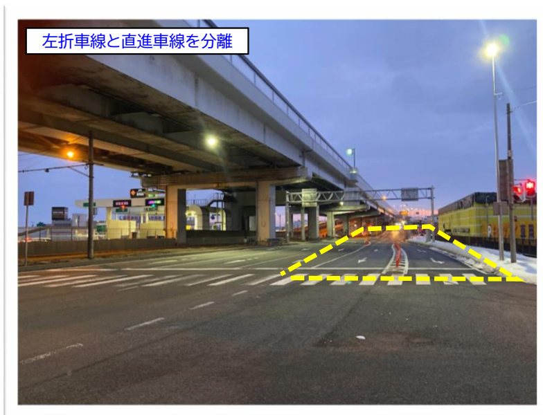
交差点における交通安全対策(国道5号 札幌市)
