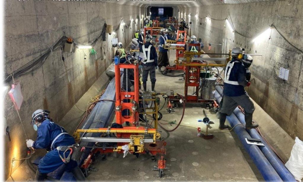
【美沢川函渠耐震補強 施工状況】
