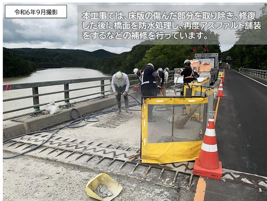
【国道274号 雨霧橋の橋梁補修(夕張市)】
