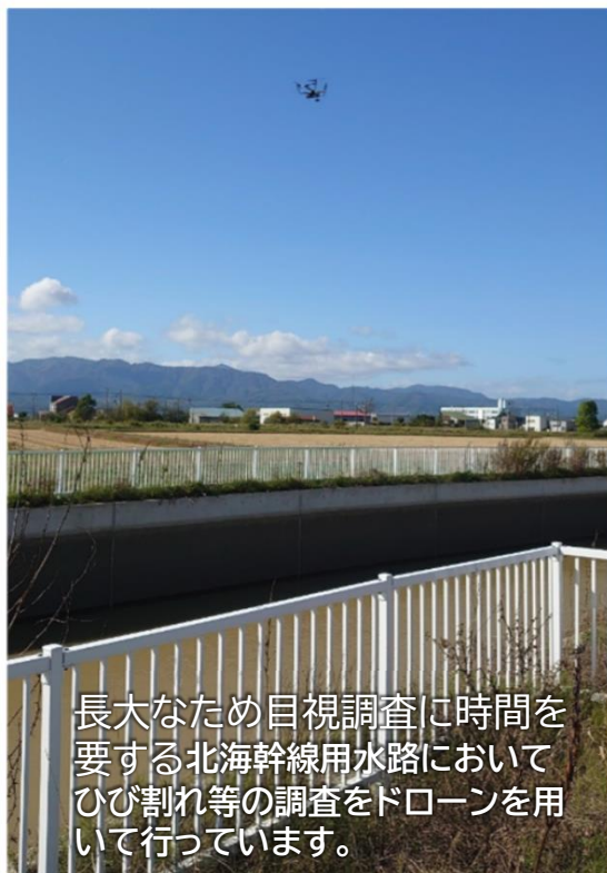
ドローンを活用した 北海幹線用水路（美唄市）の機能診断
