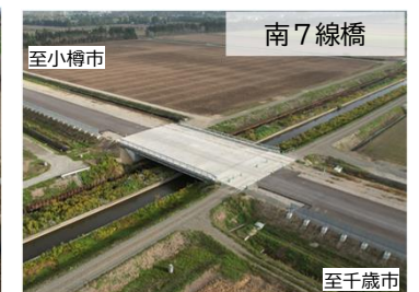
橋 長:24m 橋梁形式:PC単純中空床版橋 逆T式橋台
