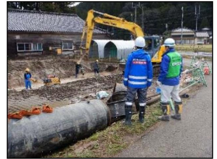
【復旧工事の状況】
