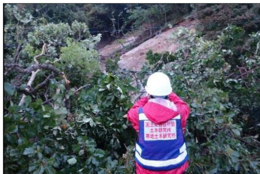
【国道付近地すべりの現地状況】
