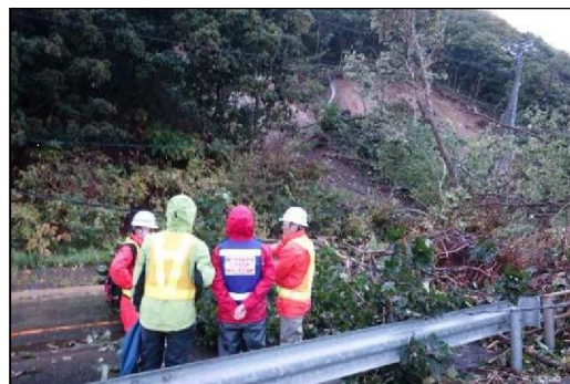
【道路管理者との打合せ状況】
