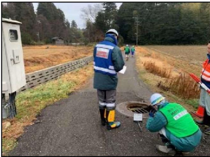
【農業集落排水施設の調査】
