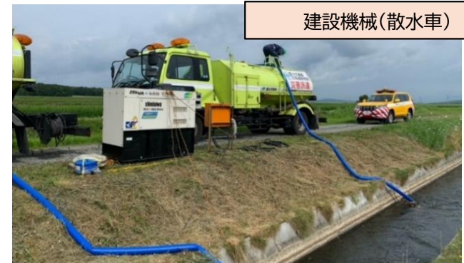
【農業用水確保のための給水支援(散水車)(R6.7 北竜町)】
