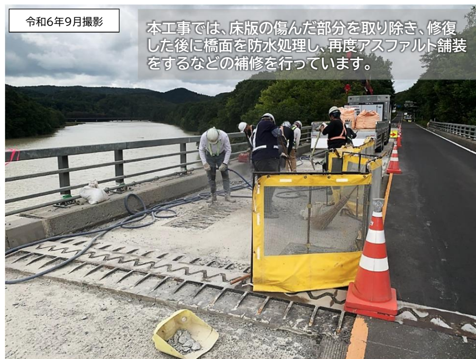
【国道274号 雨霧橋の橋梁補修(夕張市)】
