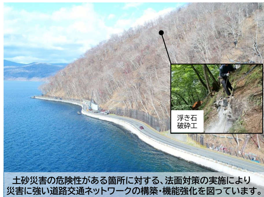
【土砂災害防止対策(国道453号 斜面对策の整備)】
