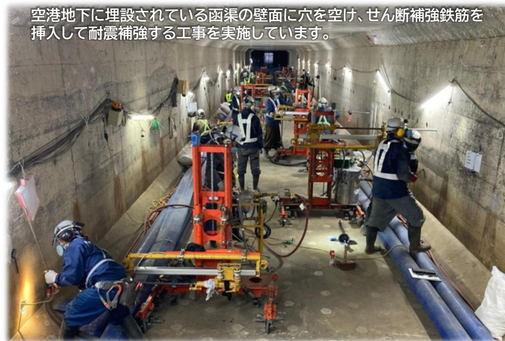
【美沢川函渠耐震補強 施工状況】
