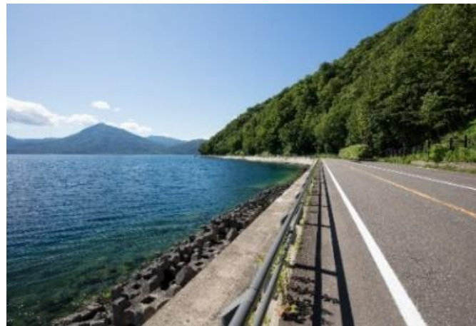
支笏洞爺二セコルートウエルカム北海道工リア (国道453号千歳市幌美内国有林L=9 km)
