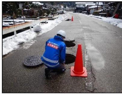
【被災施設の調査】
