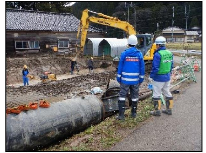
【復旧工事の状況】
