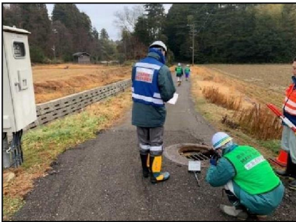
【農業集落排水施設の調査】
