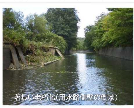
【農業水利施設(用水路)の整備】 国営かんがい排水事業北海地区
