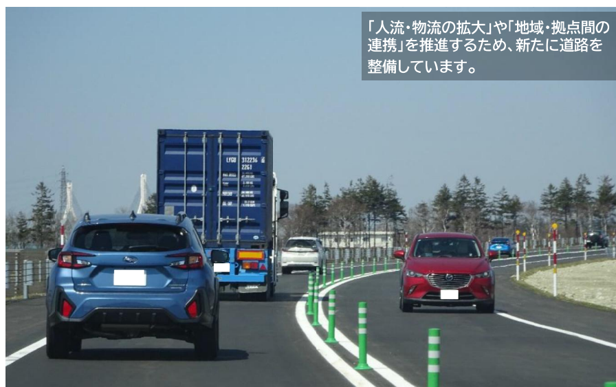
【道央圏連絡道路 中樹林道路(江別市、南幌町)】 (令和7年3月15日開通)
