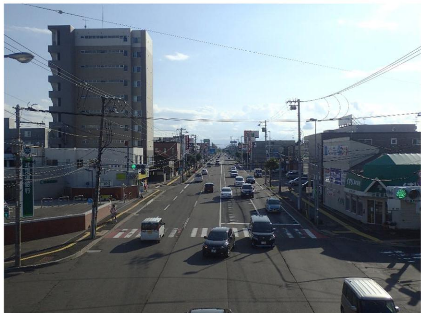
【整備前】(国道12号江別市野幌町)
