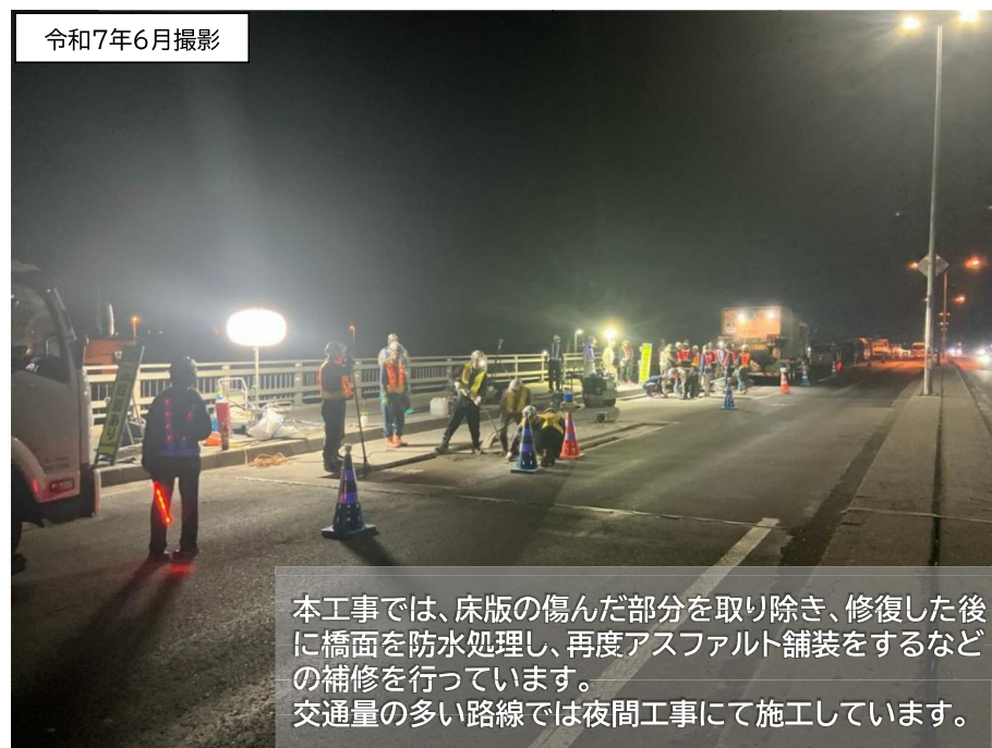
【国道275号 雁来大橋の橋梁補修(札幌市)】
