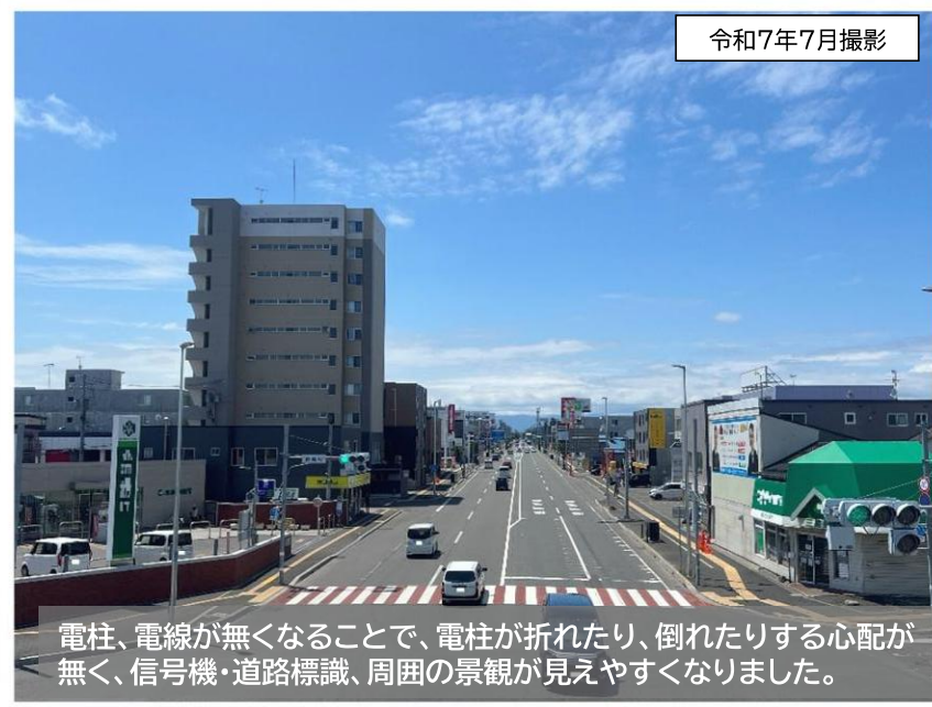
【整備後】(国道12号江別市野幌町)
