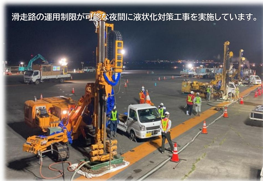
【滑走路液状化対策 施工状況】
