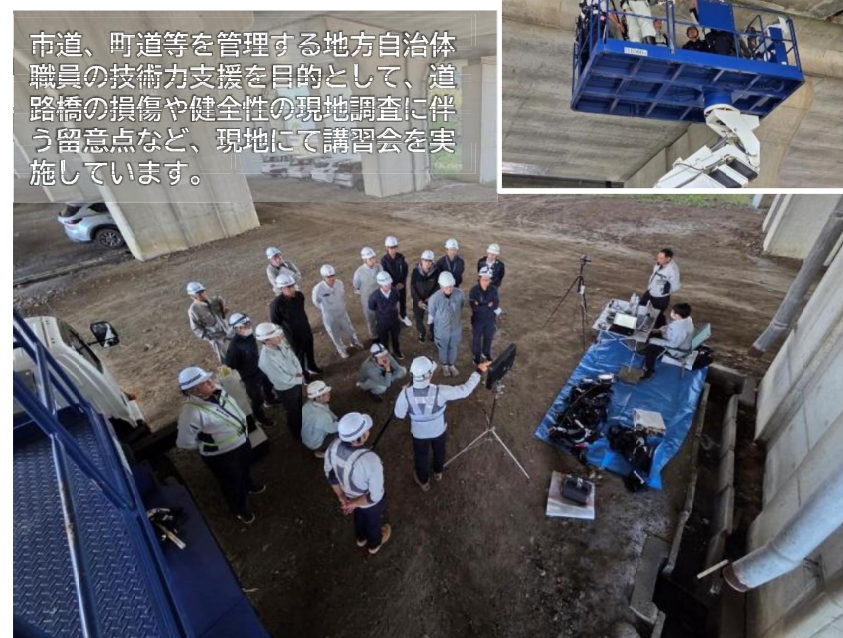
桁下打音調査(高所作業車) →
