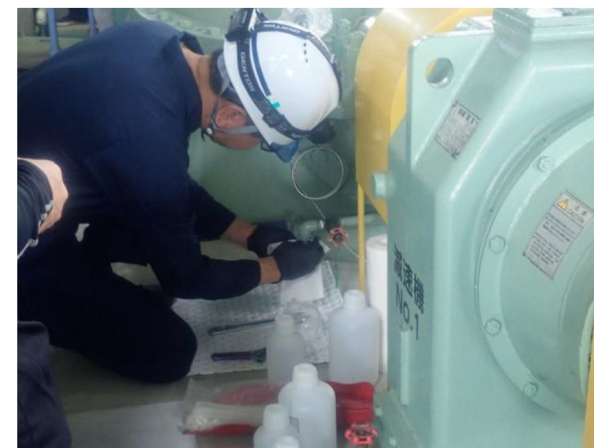
排水機場（新十津川町）の ポンプ設備内の潤滑診断調査
