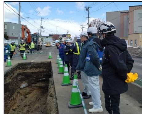
道路陥没における技術指導② 【開削による大規模空洞の確認状況】
