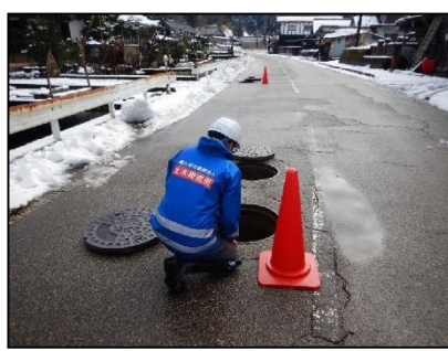
【被災施設の調査】
