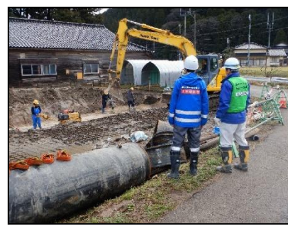
【復旧工事の状況】
