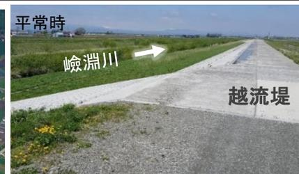
嶮淵川の水を越流堤から導水して遊水地へ貯留しました。
