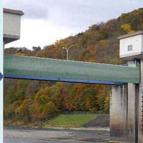
ゲートの塗装
