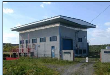
江別太排水機場 (昭和46年完成)
