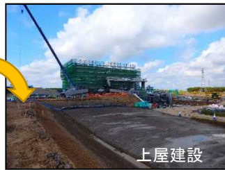
北島排水機場（新設）
