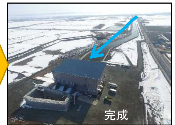
排水ポンプ設置
