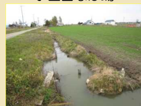
未整備な排水路
