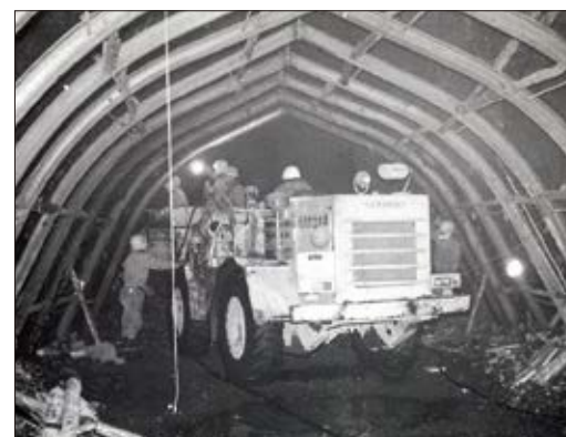
仮排水路トンネル工事／昭和42年(1967年)
