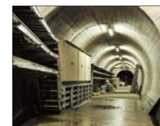
監査廊内設備点検
