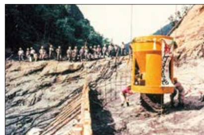
堤体コンクリート打設開始／昭和44年(1969年)
