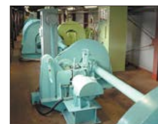
放流設備点検
