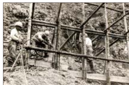
堤体モルタル吹付工／昭和44年(1969年)
