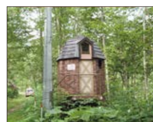
雨量・水位観測施設
