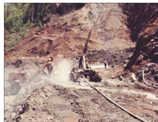
堤体基礎掘削工事／昭和43年(1968年)
