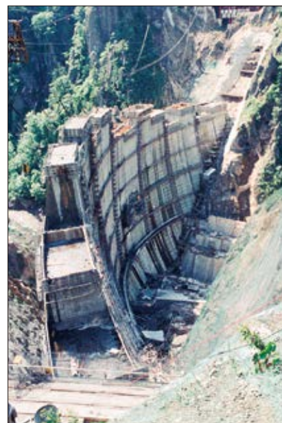
堤体コンクリート打設工事／昭和46年(1971年)
