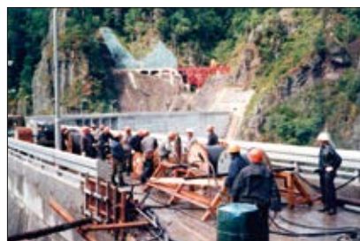
管理用設備配線工事／昭和47年(1972年)
