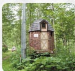
雨量・水位観測施設
