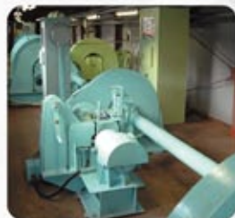
放流設備点検
