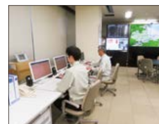
放流設備操作
