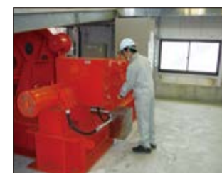
放流施設点検
