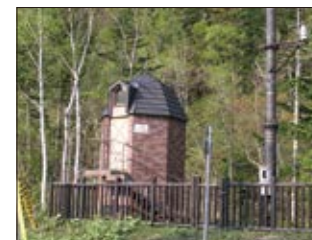
雨量・水位観測施設
