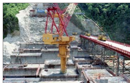
堤体コンクリート打設開始／昭和57年(1982年)
