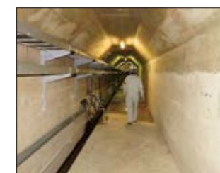
監査廊内設備点検
