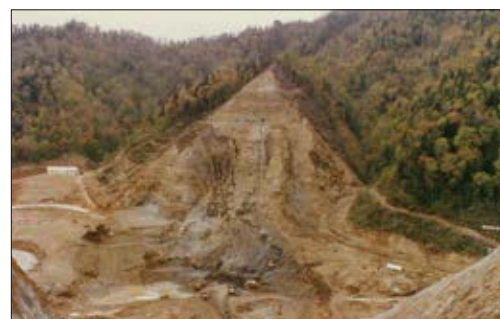
堤体基礎掘削工事／昭和56年(1981年)
