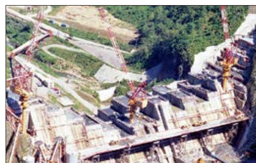
堤体コンクリート打設工事／昭和60年(1985年)
