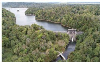
雨竜第2ダムは、昭和18(1943)年に完成した重力式コンクリートダムです。連絡水路により朱鞠内湖への導水を行っていますが雨竜川ダム再生事業により発電容量の一部を洪水調節容量に振り替えます。
