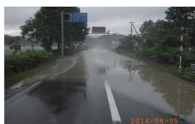
平成26年8月洪水 （国道275号冠水状況）
