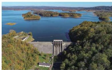
雨竜第1ダムは、昭和18(1943)年に完成した重力式コンクリートダムです。発電用のダムとして建設されましたが、雨竜川ダム再生事業により発電容量の一部を洪水調節容量に振り替えます。貯水池である朱鞠内湖は、ダム湖としては日本最大の湛水面積を誇ります。
