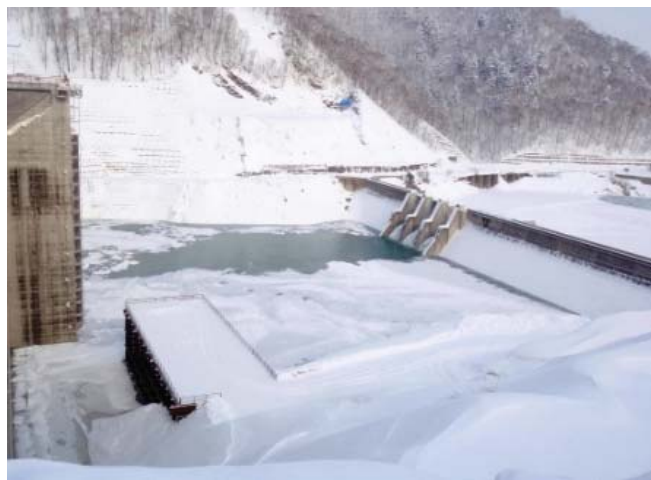
2014/3/6 試験湛水 貯水位 249.5m
