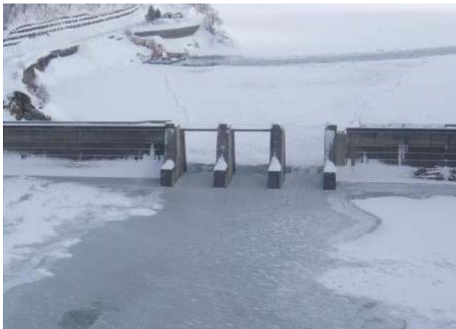
2014/3/7 試験湛水 貯水位 256.0m
