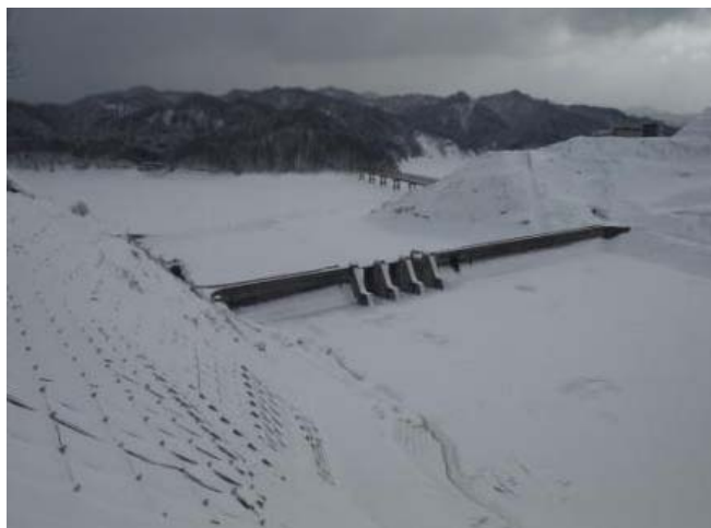
2014/3/10 試験湛水 貯水位 256.3m
