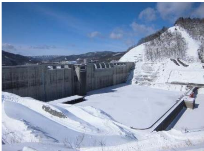
2014/3/12 試験湛水 貯水位 256.4m
