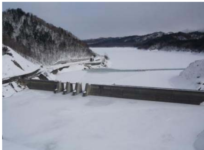
2014/3/13 試験湛水 貯水位 256.4m
