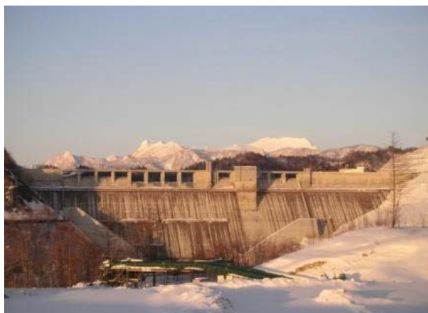
2014/3/17 試験湛水 貯水位 256.6m
