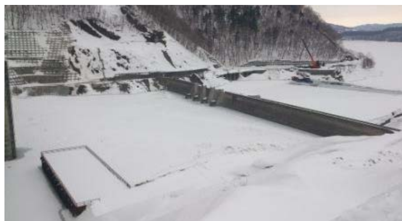
2014/3/18 試験湛水 貯水位 256.7m
