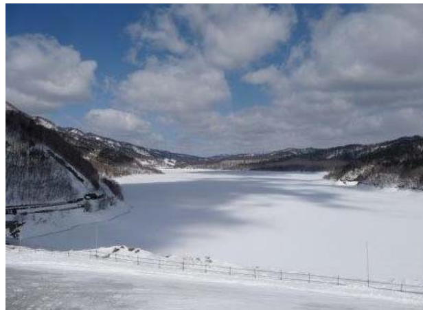
2014/3/19 試験湛水 貯水位 256.8m
