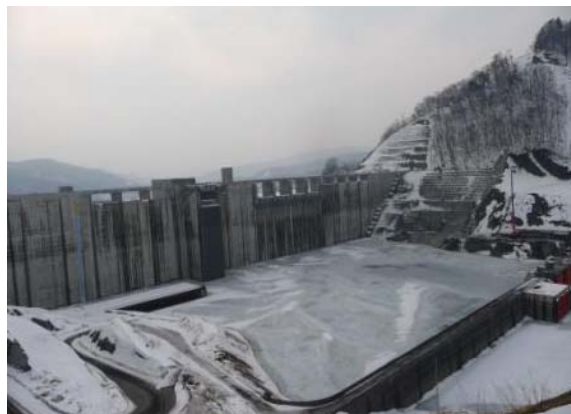
2014/3/25 試験湛水 貯水位 257.4m
