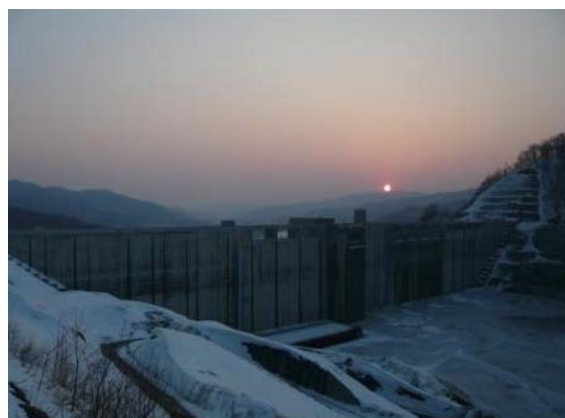
2014/3/26 試験湛水 貯水位 257.5m
