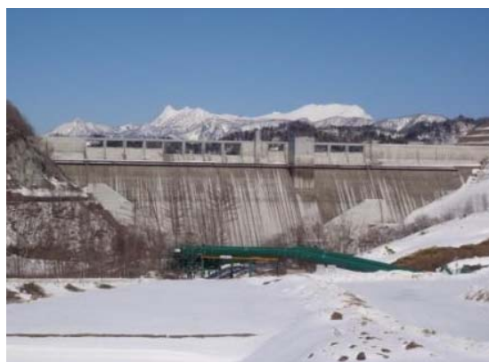
2014/3/27 試験湛水 貯水位 257.8m
