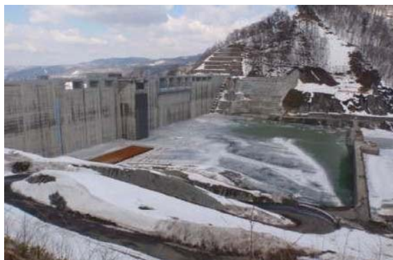
2014/4/1 試験湛水 貯水位 261.3m
