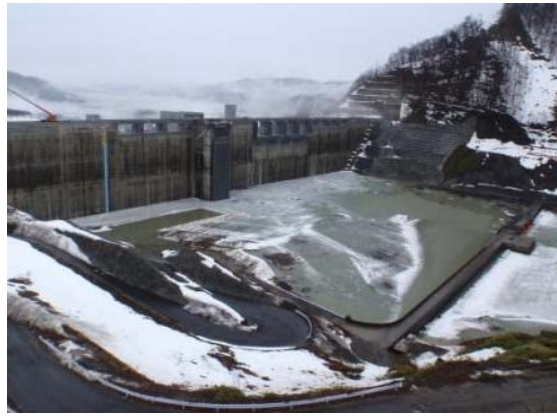
2014/4/4 試験湛水 貯水位 263.2m
